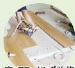
床・フローリング改修
