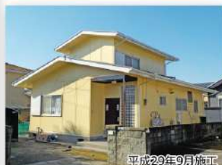
平成29年9月施工
