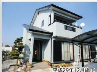
平成29年12月施工
