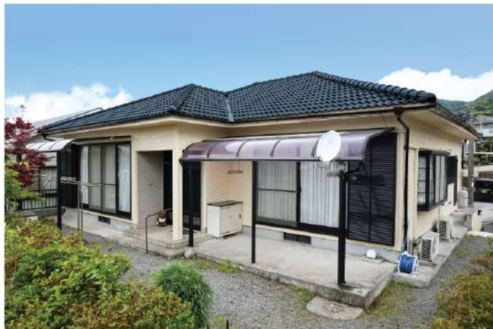
平成31年1月 屋根・外壁塗装施工
