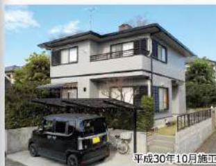
平成30年10月施工
