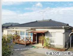
平成30年10月施工
